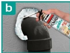
(a) Protéger les surfaces adjacentes. Secouer le produit 20 fois. La bille mélangeuse contenue dans l'aérosol sert à homogénéiser la mousse.
